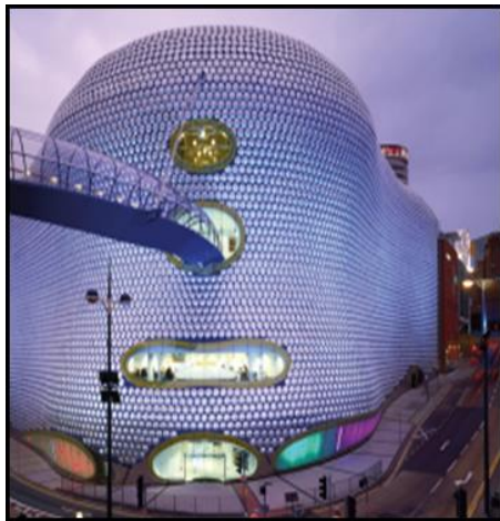
Fig 7: (d) Selfridges Building, Birmingham [12]
