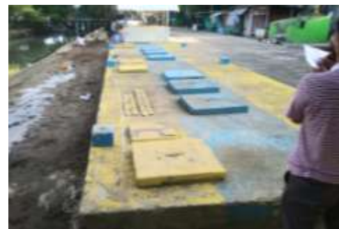
Fig. 2. Old WWTP Sekanak
