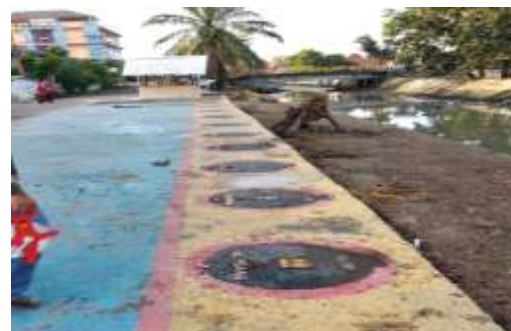
Fig. 3. New WWTP Sekanak
